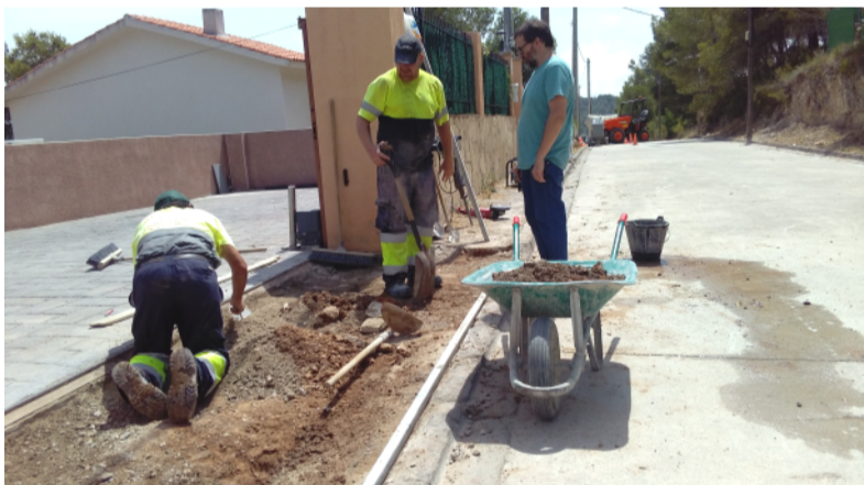
Treballs a la urbanització les Palmeres
