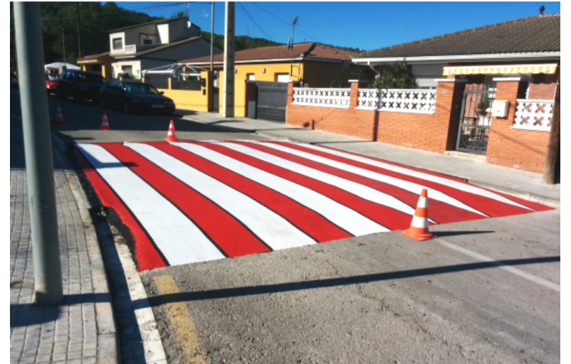
Nou pas elevat al carrer Roger de Flor
