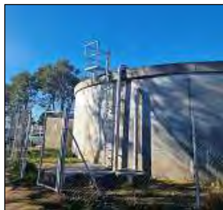
Imatge 15. Dipòsit Palmeres i Muntanya de Mar
