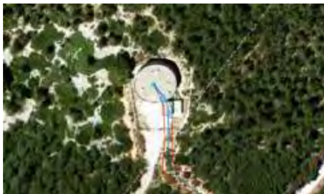
Imatge 29: Ubicació del dipòsit Daltmar
