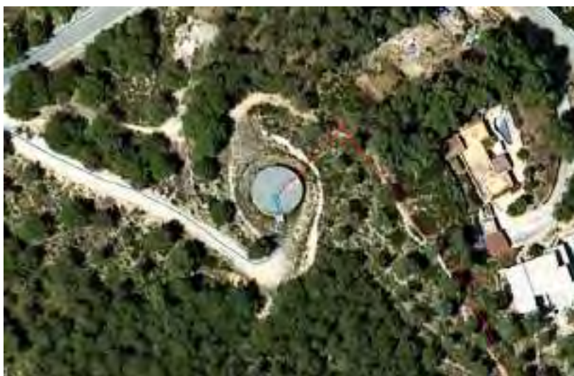
Imatge 24: Ubicació del dipòsit Alt Vora Sitges
