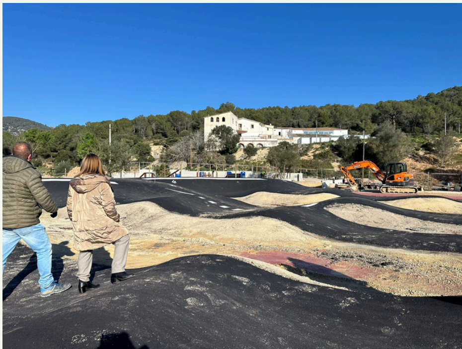
El circuit Pump track està molt avançat
